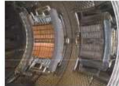
Antennes pour le chauffage hybride (Tore Surpa)
